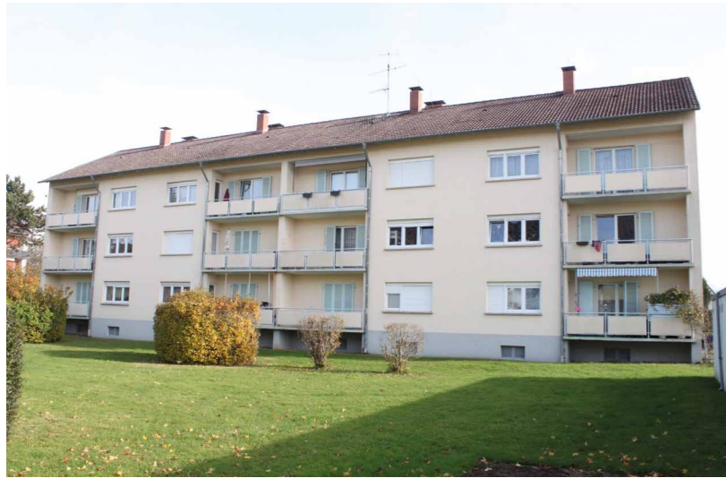
Grißheimer Weg 24, Heitersheim vor der Sanierung
